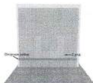
Задание 1. Установить опорную рейку и маячные ряды из плитки
