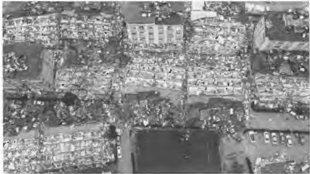
Рис. 3. Последствия землетрясения в Турции в 2023 г.
