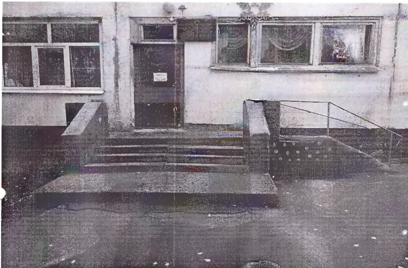
Фото № 5, на фото изображена лестница (наружная) перед входной дверью
