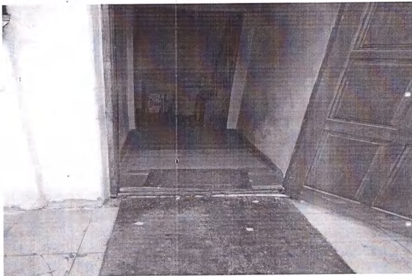
Фото № 12, на фото изображен запасной выход и пути эвакуации
