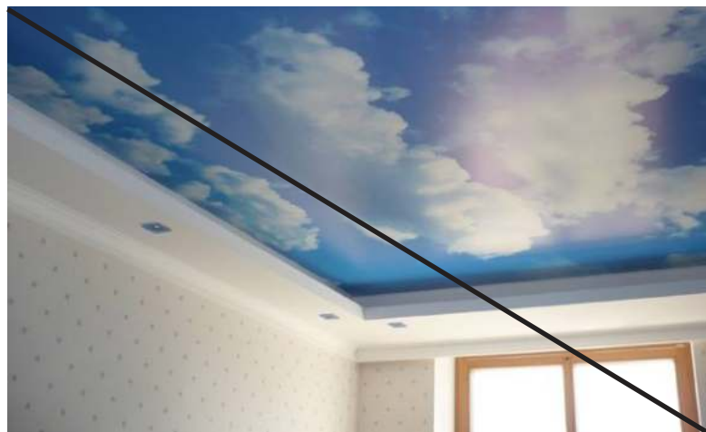
Плохо Натяжные потолки. Потолки с рисунками
