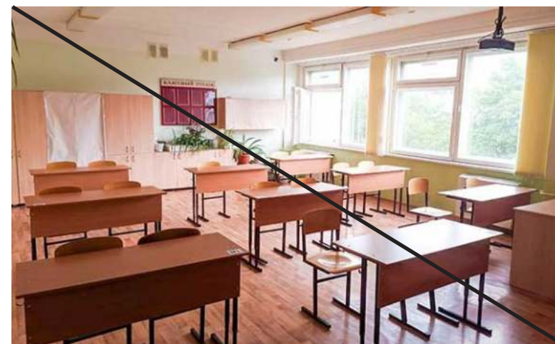
Плохо Линолеум под дерево
