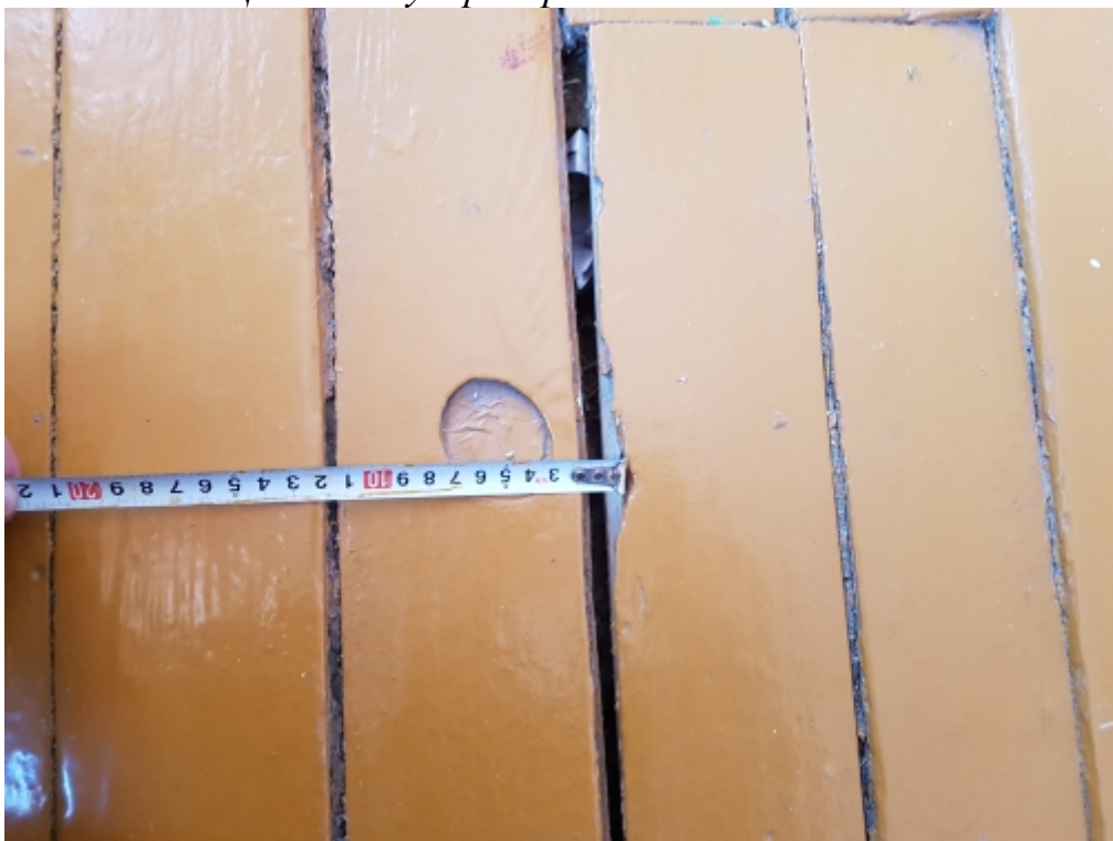
Фото №30 Щели в полу с раскрытием до 8мм .
