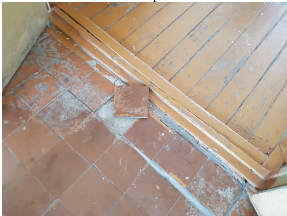
Фото №32 Сколы и отслоение керамической плитки пола.
