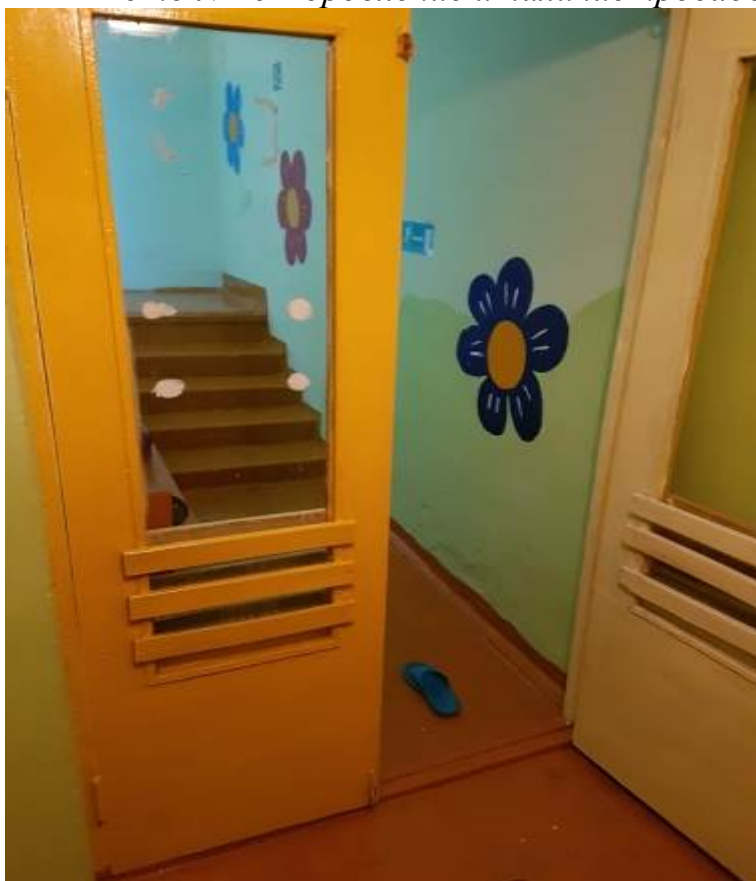
Фото №26 Коробление и наличие просадок дверного блока.
