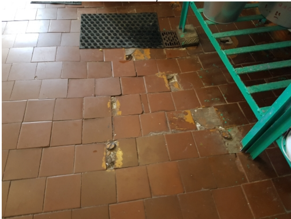
Фото №32 Сколы и отслоение керамической плитки пола.
