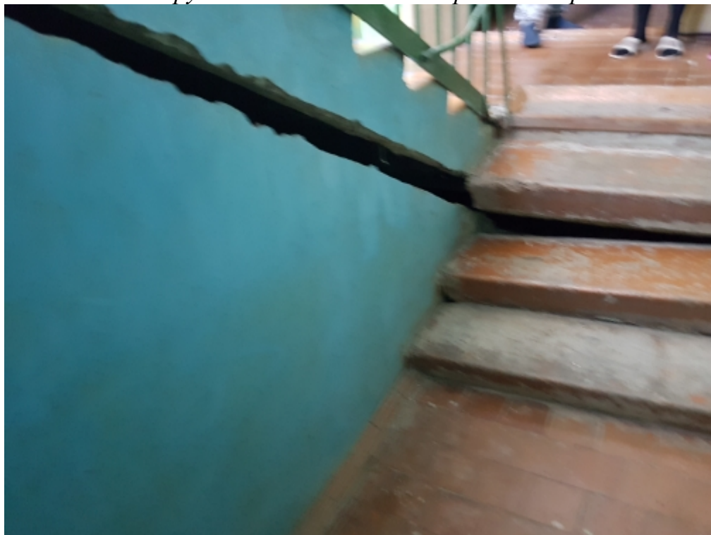
Фото №18 Разрушение лестничного марша пожарного выхода.
